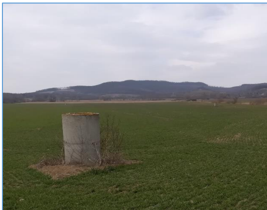
8. ábra: Nyitott betongyűrűs drénakna Mindszentkállától DK-re.
