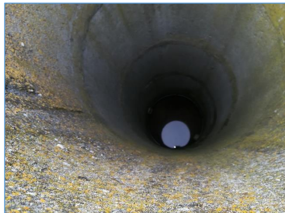
8. ábra: Nyitott betongyűrűs drénakna Mindszentkállától DK-re.
